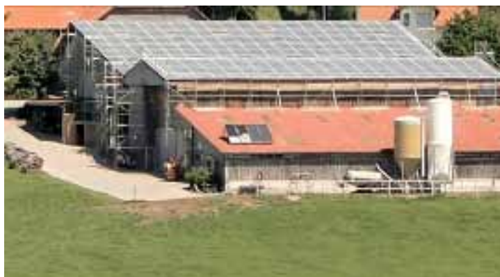
Dach mit 700 Quadratmeter Fotovoltaik-Anlage inkl. kleine thermische Solaranlage für den Eigenbedarf (vorne links)
