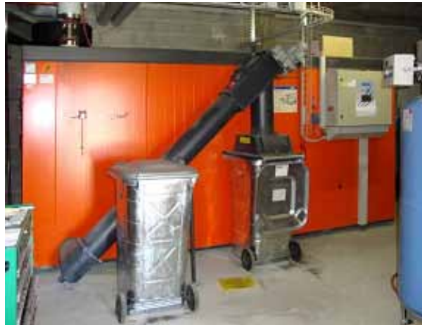
Kessel der Pellet-Heizung, mit der rund 80 Haushalte mit Heizenergie versorgt werden können
